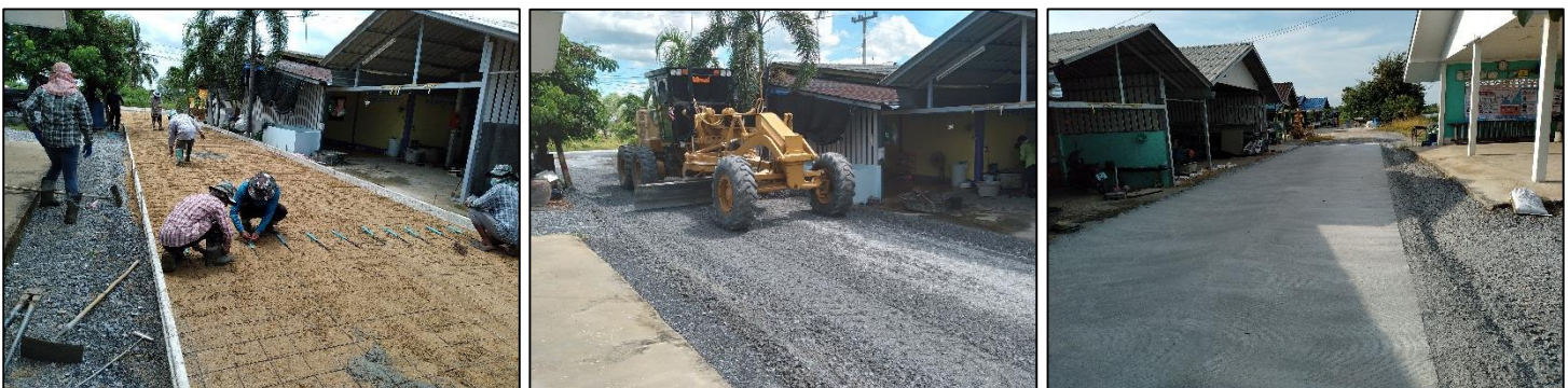
โครงการก่อสร้างถนนคอนกรีตเสริมเหล็กบ้านใหม่โพธิ์ศรี หมู่ที่ ๑๑ (ข้างศาลาประชาคม)
